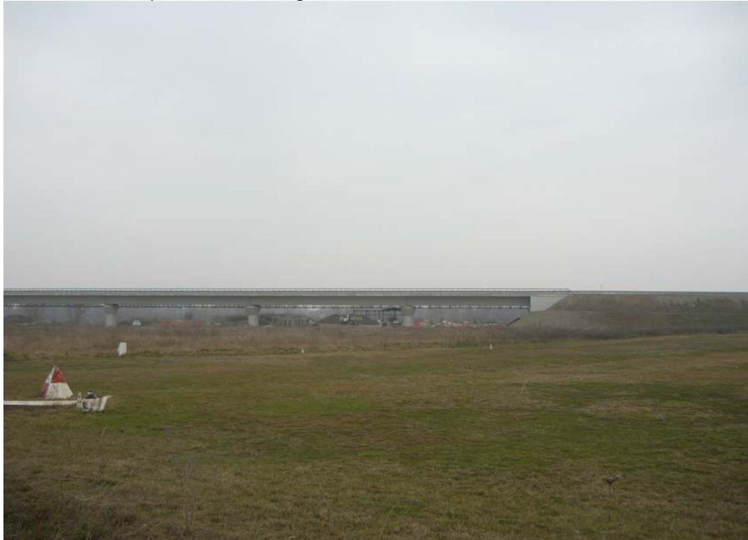
FOTO 1: Nuovo ponte della tangenziale di Piacenza: vista da monte
